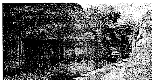
Une entrée de la carrière Le Grand Plantier. On voit le « duria » qui forme au premier plan linteau et supporte la pierre tendre inexploitée.
