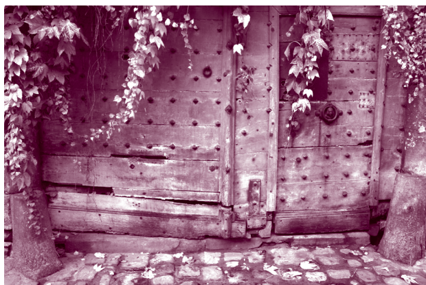
La menuiserie du portail s'affaisse sur le seuil et les lames de bois se dissocient sous l'effet de la déformation des pièces forgées.
