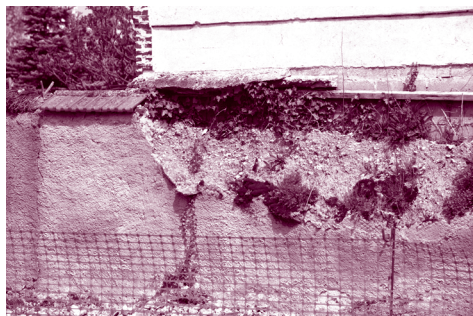
La disparition partielle du couronnement de protection entraîne, à moyen terme, la ruine du mur de clôture en bauge.
