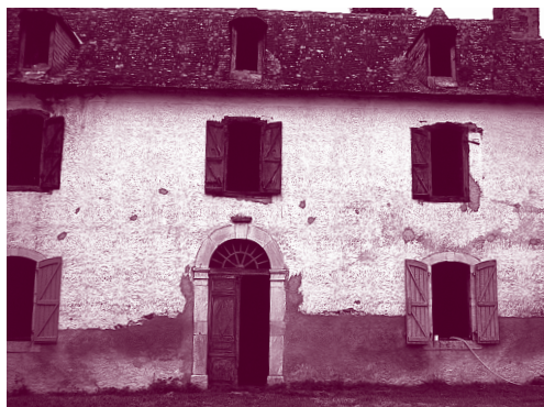
La base des murs est un endroit particulièrement sensible pour les enduits.
